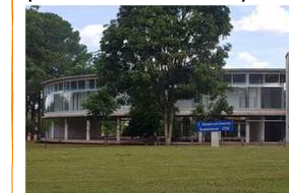
CDS (conclusão do primeiro pavimento do Bloco B)
